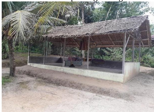
Gambar 2. Pondok yang terdapat di sekeliling kolam pancing
